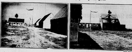
Die Arbeiter sind mit dem Bau der neuen Siedler-Häuser beschäftigt. Die Arbeiter sind mit dem Bau der neuen Siedler-Häuser beschäftigt.
