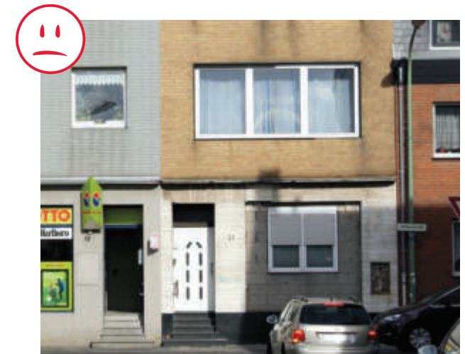
Abb. 35.4 nicht gelungener Umbau eines ehemaligen Ladengeschäftes zu Wohnraum
