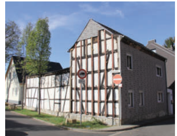
Abb. 19.3 Fachwerkfassade wird freigelegt
