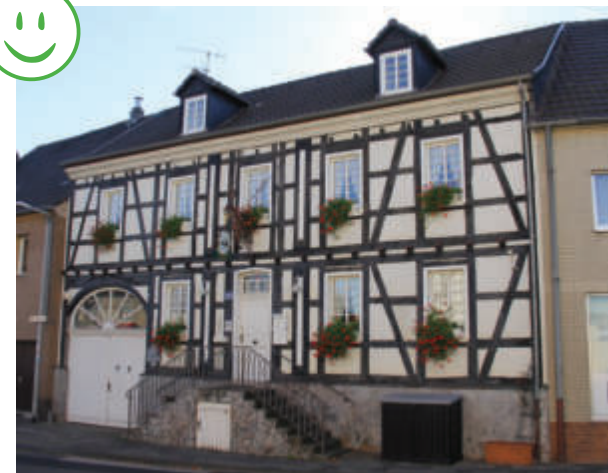
Abb. 34.3 das Fachwerk gibt konstruktiv die Fensteranordnung vor
