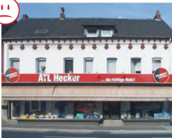
Abb. 49 totale Horizontalzäsur der Fassade zwischen EG und OG
