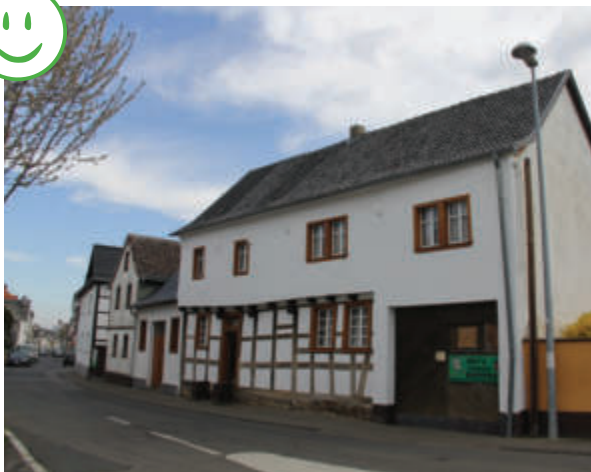
Abb. 28.1 Fachwerk-Ensemble Zur Tomberger Mühle und Buschstraße
