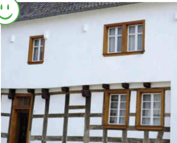
Abb. 43.1 Fenster- und Türumrahmungen typische Fachwerk-Faschen aus Holz
