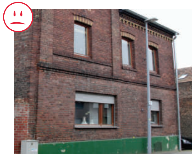
Abb. 35.3 veränderte Fensterformate im Erdgeschoss
