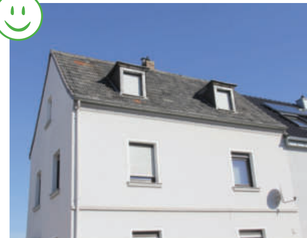
Abb. 32.4 Satteldach mit auf die Fassadengliederung abgestimmten Dachgauben
