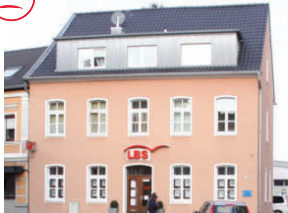
Abb. 33.2 Dachgaubenband passt nicht zur Gebäudearchitektur
