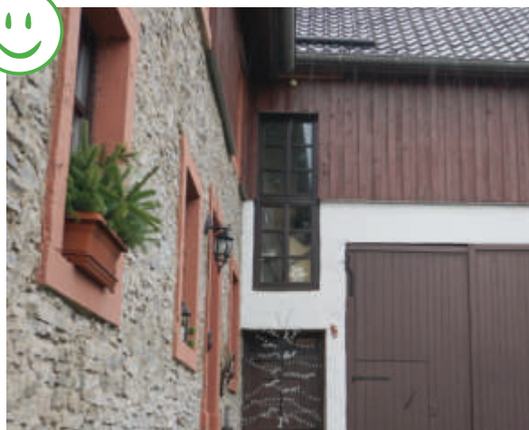
Abb. 43.2 Scheunenausbau mit vertikal-em Fensterband: „Altes mit neuem Akzent“
