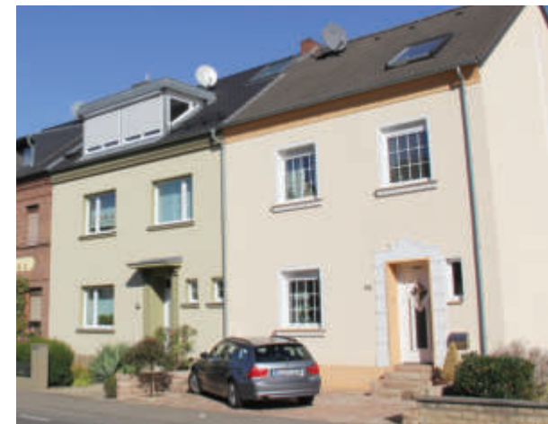
Abb. 22.3 Fassadengestaltung aus den 1920/ 30er Jahren
