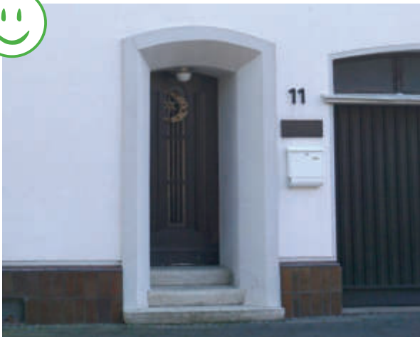
Abb. 37.2 Gewände und Außentreppe
