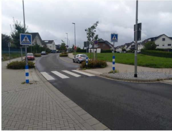
Beispiel FGÜ mit vorgezogenem Seitenraum (Foto: VIA eG)
