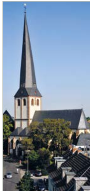
5 - Kath. Pfarrkirche St. Martin, Kirchstraße
