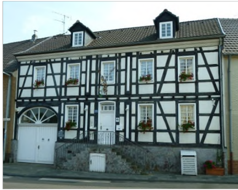
Abb. 50: Prägende Fassade im zentralen Bereich der Kuchenheimer Str. Quelle: Eigene Fotografie 2015
