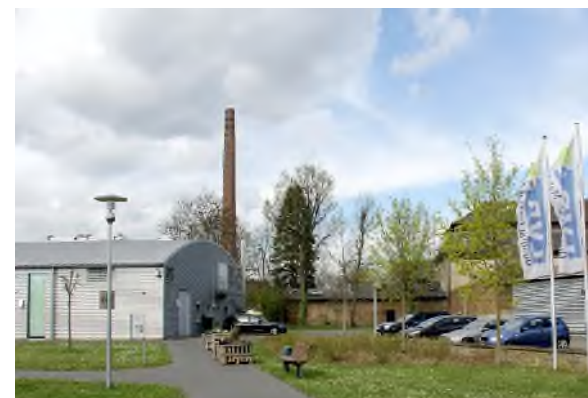
Abb. 67.3 Schornstein der ehem. Tuchfabrik
