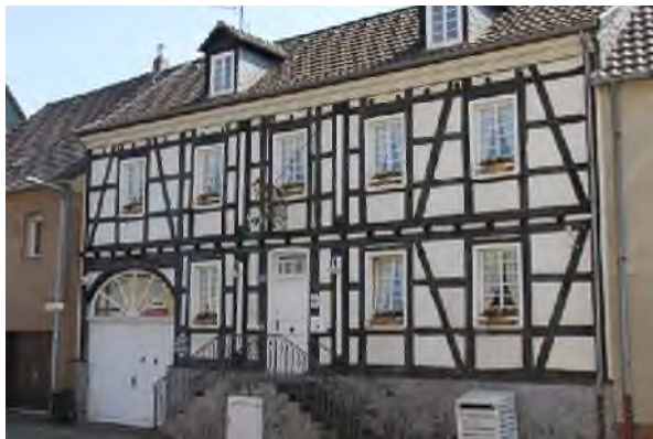
Abb. 68.1 Fachwerk Kuchenheimer Straße
