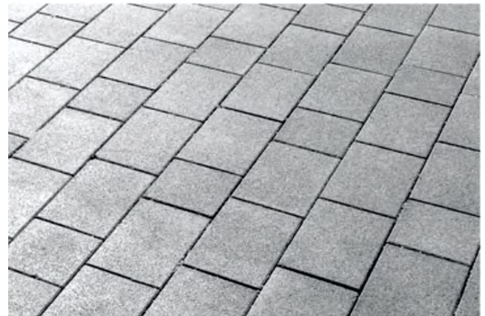
Abb. 34.2 Betonsteinpflaster - Verlegung im Reihenverband
