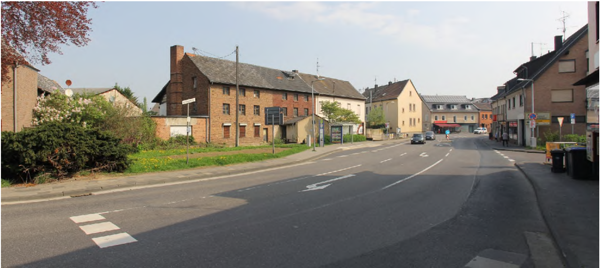
Abb. 30 Kuchenheimer Straße - Abschnitt zwischen Carl-Koenen-Straße und Bachstraße mit großzügigem Straßenraumquerschnitt
