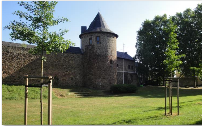
Abb. 47: Historische Stadtmauer am Disternicher Torwall
